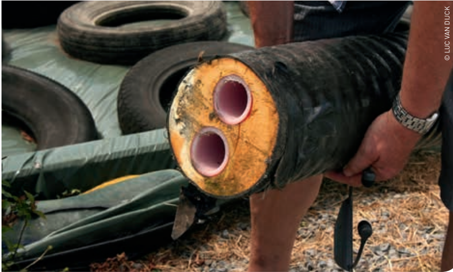
Het 1500 m lange netwerk van leidingen bestaat uit dikke goed geïsoleerde buizen die op 1,4 m diepte ingegraven zijn.
